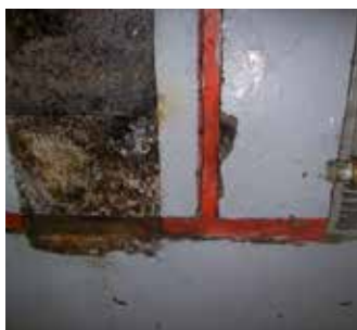
Junta deteriorada
